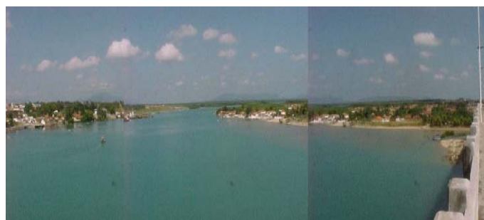
Figura AVP 95. Visão panorâmica do estuário do Rio Ceará, a montante da ponte que liga Fortaleza a Caucaia
