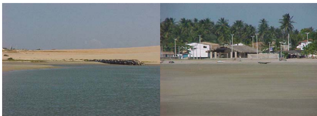
Figura AVP 90. Estuário do Rio Mundaú evidenciando um dos espigões utilizados no processo de desvio da desembocadura do rio
