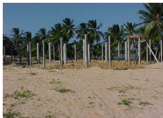
Figura AVP 87. Obras do CPTA do Lagamar do Trairi. Observa-se a manutenção das carnaúbas
