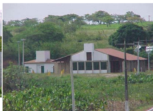
Figura AVP 82. Detalhe das edificações do CPTA da Lagoa da Canabrava
