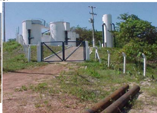
Figura AVP 67. Instalações da CAGECE na Lagoa do Pecém
