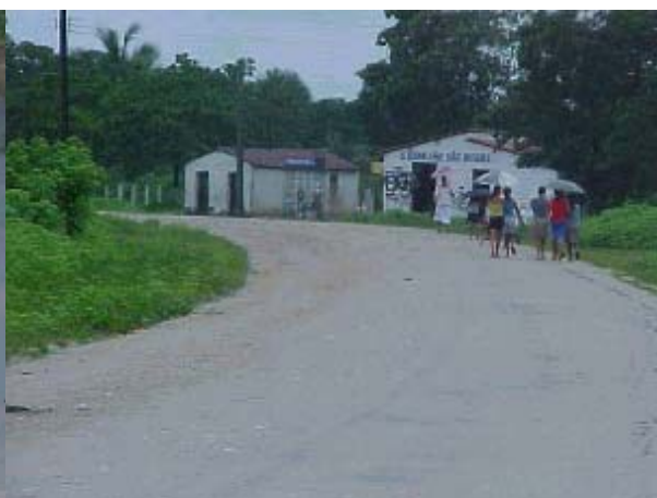
Figura TRA 09. O traçado existente passa por um vilarejo com algumas edificações
