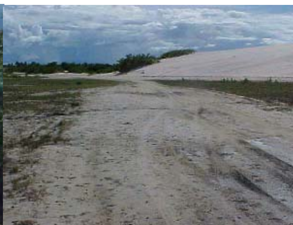
Figura TRA 11. Trecho inicial em Tatajuba, existência de Área de Preservação Ambiental (Dunas)
