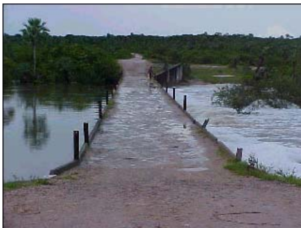
Figura TRA 03. Detalhes dos balizadores no trecho de passagem molhada
