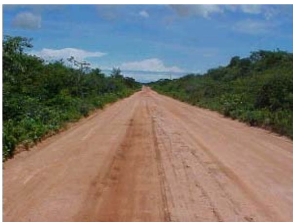
Figura TRA 14. Trecho da estrada em revestimento primário em boas condições
