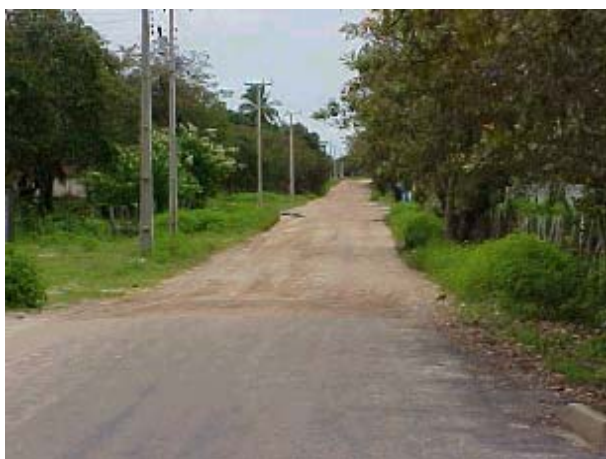
Figura TRA 16. Trecho em boas condições
