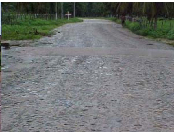
Figura TRA 19. Trecho urbano em Itarema, 200m em Pedra Poliédrica
