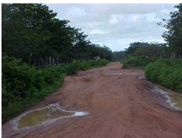
Figura TRA 12. Estrada precária com muitos buracos e pontos de alagamento
