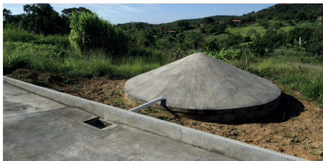
Imagem de cisterna no semiárido (Tipo calçadão)
