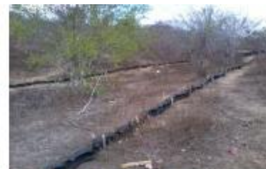
Implantação de 150 m de Tratamento Linear com Revestimento de Pneus.
