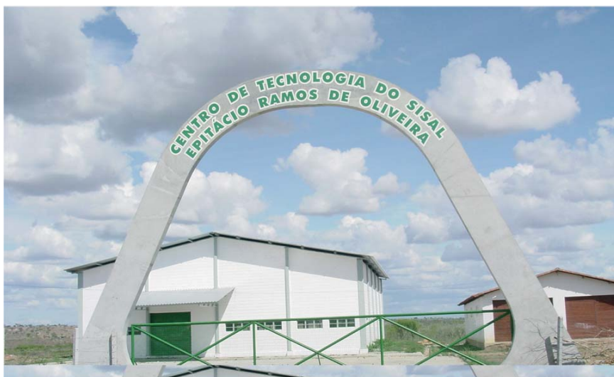
Foto 20 - Visão de uma das edificações destinadas a abrigar o Centro de Tecnologia do Sisal, em Valente (BA)
