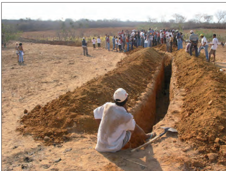
Foto 7 – Construção de Barragem Subterrânea
