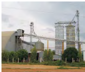
Foto 14 – Silo da empresa Cargill, Balsas (MA)
