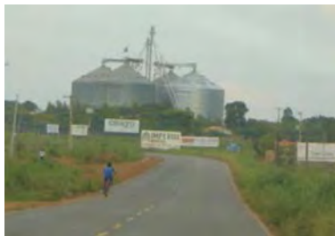
Foto 16 – Silo da Empresa Cargill, Balsas (MA)
