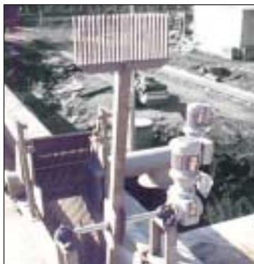
Foto 2 – Dispositivo de Remoção Mecanizada
