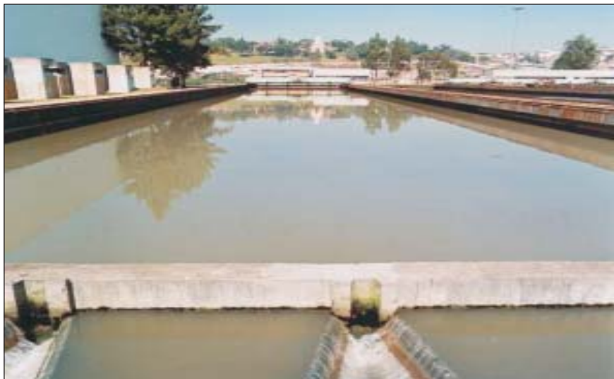
Foto 7 – Decantador Retangular
