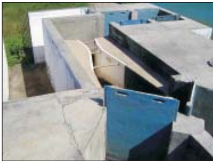
Foto 4 – Medição de Vazão Através de Calha Parshall
