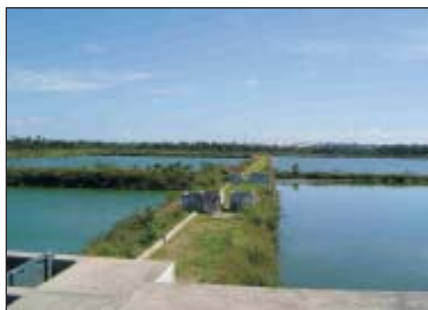
Foto 10 – Vista de um Sistema de Lagoas de Estabilização
