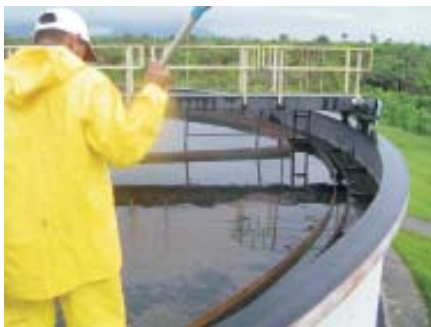
Foto 8 – Decantador Circular
