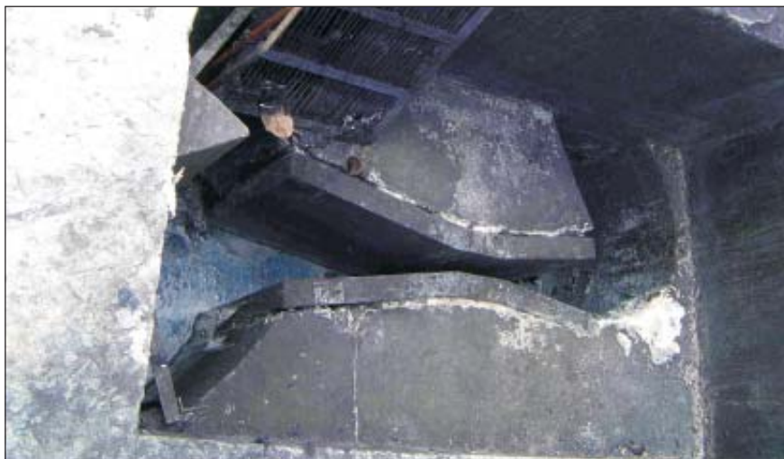
Foto 26 – Medidor de Vazão e Entrada do Esgoto no Tanque de Equalização
