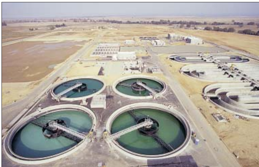
Foto 12 – Vista de uma ETE Composta de Sistema de Lodos Ativados
